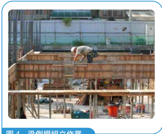
圖 4 梁側模組立作業
