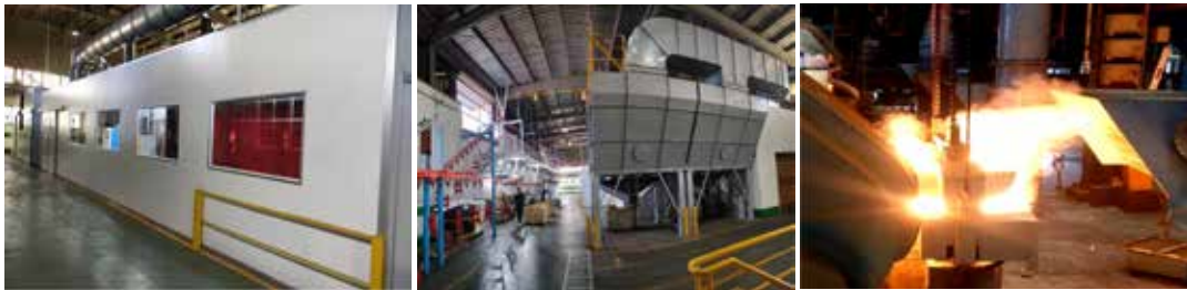
改善後爐區與噴塗作業集塵設備效果
