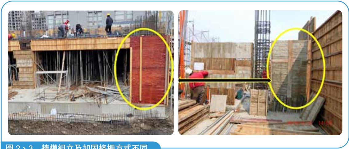
圖 2、3 牆模組立及加固格柵方式不同
