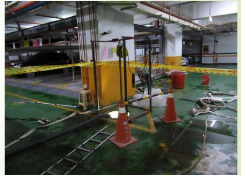
災害發生場所未置備監測儀器、換氣裝置等相關安全措施
