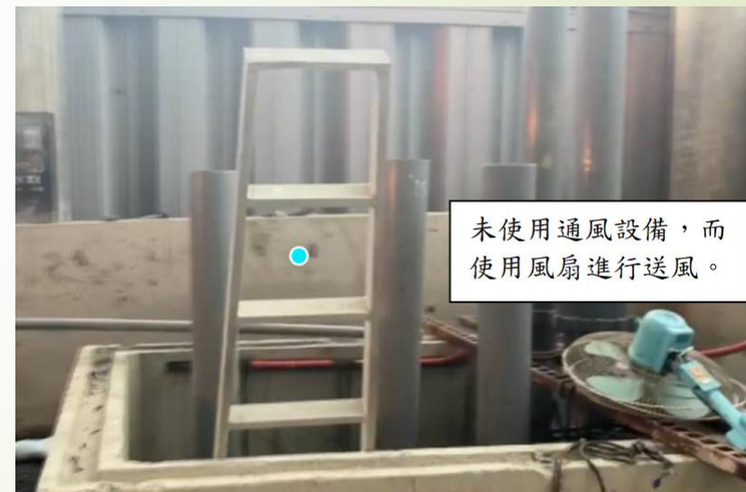
高雄某魚電共生廠勞工掉入汗水井災害現場
