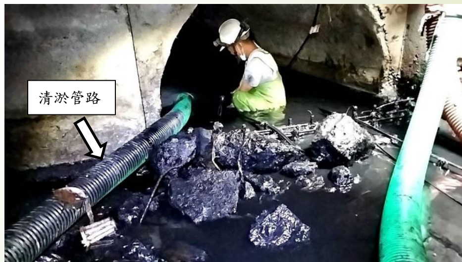
管徑 800mm 以上的管線應由管線內作業員進行清淤
