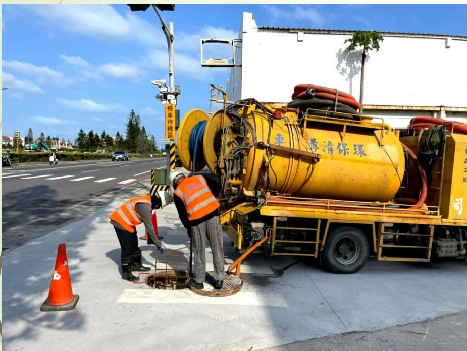
管徑 800mm 以下的管線一般用高壓清洗車清淤
